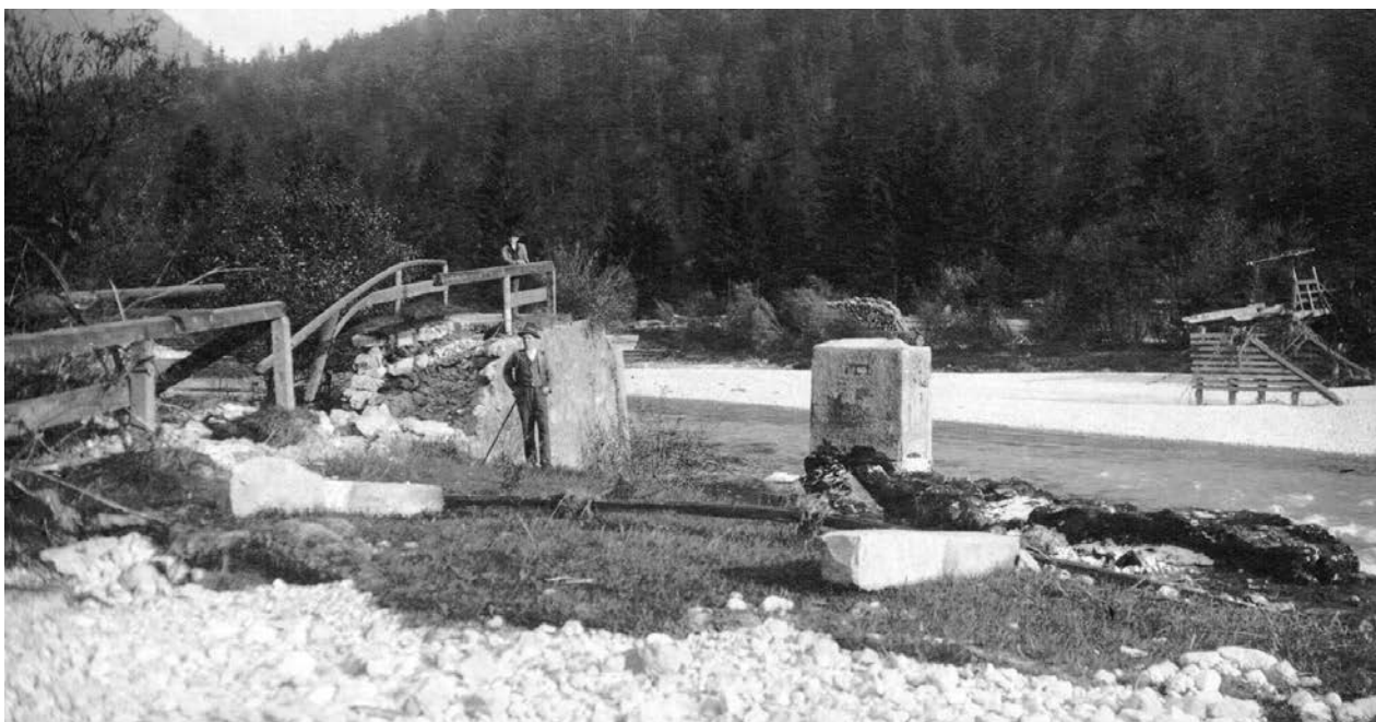
Schulsteg vom Hochwasser zerstört
