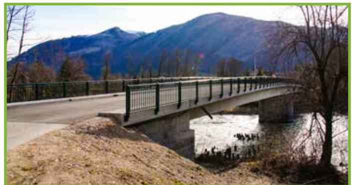
sichtlich im Frühjahr durchgeführt. Mit Hängegerüsten wird dann die Oberfläche der Betonkonstruktion passiviert, um die Lebensdauer an die der restlichen Brückenkonstruktion anzugleichen.
