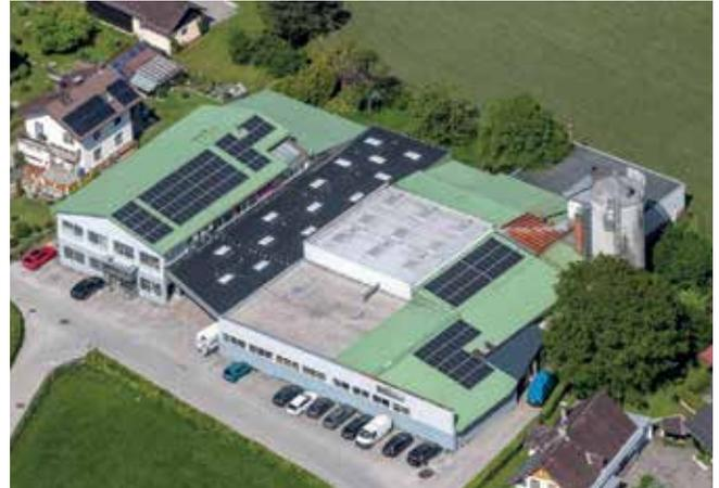
Abb.: Die Tischlerei handelt klimaaktiv & nachhaltig, auch eine Photovoltaikanlage wurde 2019 am Firmendach installiert.
