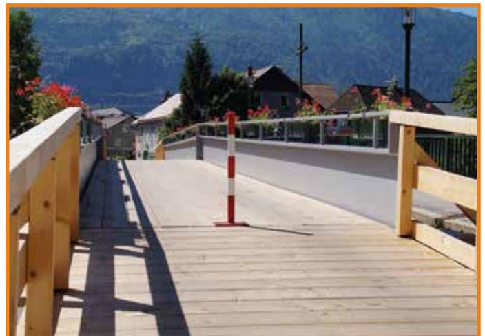
Mittlerweile wurde eine Behelfsbrücke in der Kombination Stahl-Holzkonstruktion hergestellt. Der Holzbelag wird noch mit einer rutschhemmenden Versiegelung ausgestattet werden.
